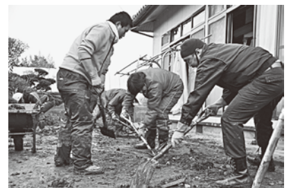
がれき撤去作業も（ロシナンテス 撮影）
