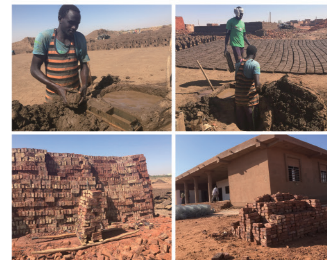
レンガは、製造から積み上げまで、すべて手作業でおこなわれます。土を採掘してレンガをつくり、積み上げる。地道な作業が続きました
