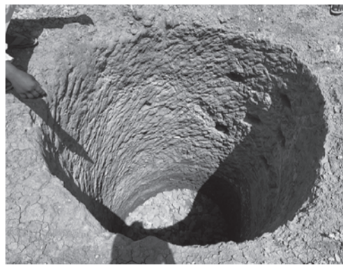
深く掘り、岩盤などが無いことを確かめました
