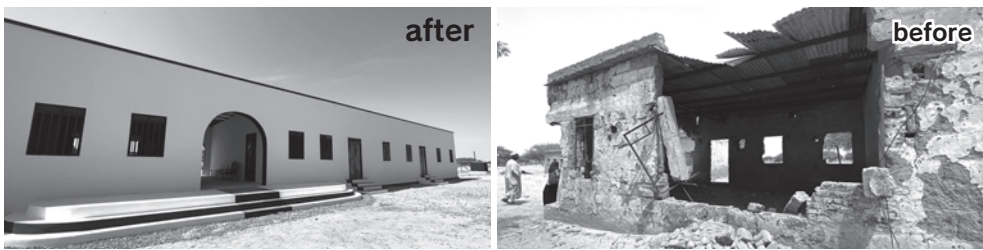
ボロボロだった校舎を補修したり新しく建設したりしました
