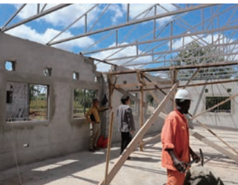
建設中のマザーシェルター
