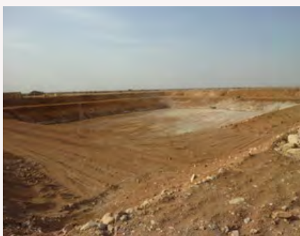
水量確保のために貯水池を掘削（深さ4m）
