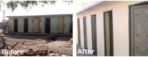
アルフハダ・ボーイズシェルターのトイレ
