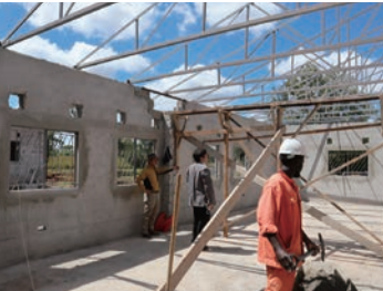
建設中のマザーシェルター
