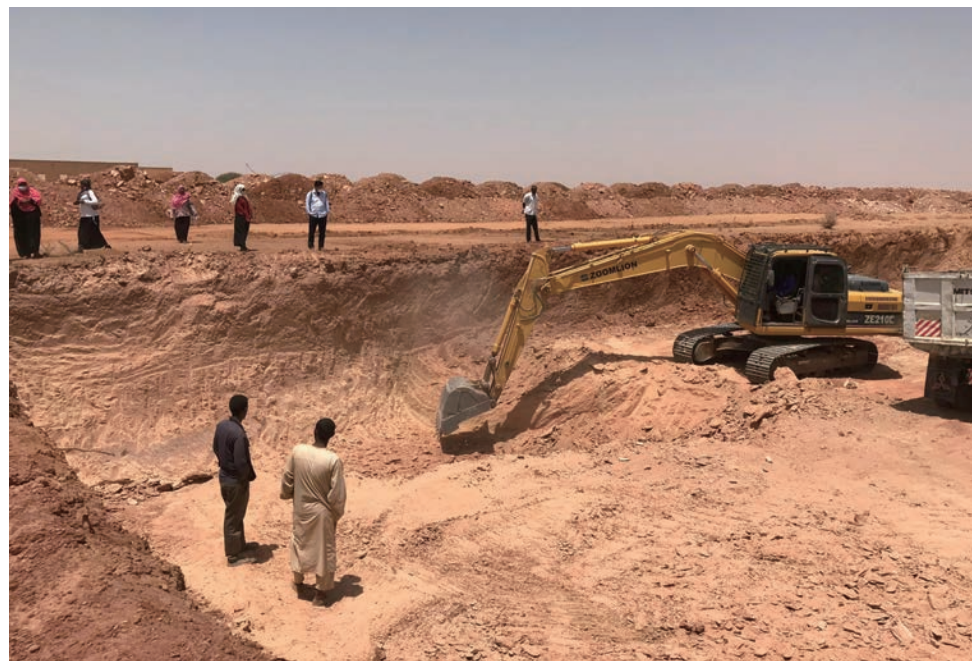
深さを出すための掘削の様子
