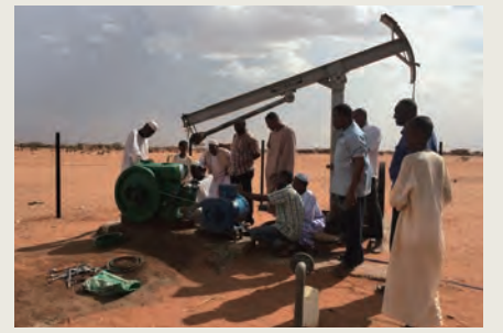
地下水を汲み上げるために必要な発電機を設置
