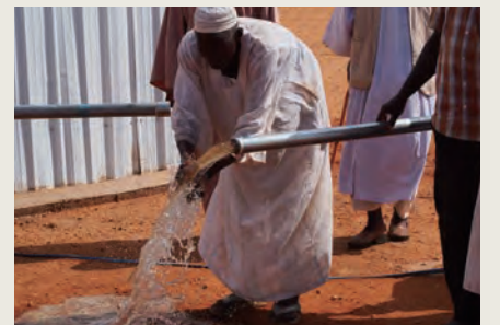
実際に水が出るかどうか試験を行いました
